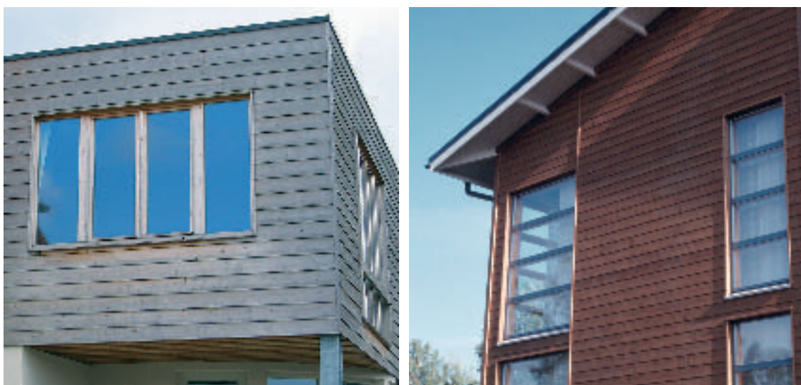
Zwei ThermoWood-Wandverkleidungen nach drei Jahren Witterungseinwirkung, einmal ohne und einmal mit Schutzanstrich.
